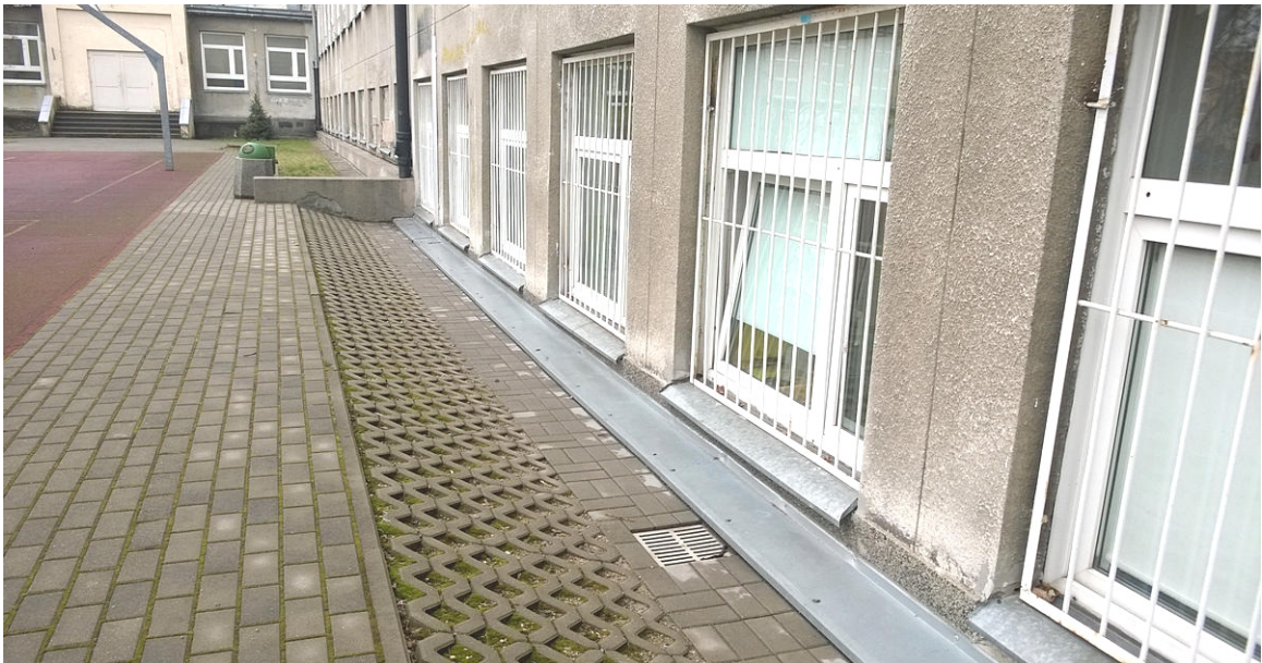
Okna stołówki na poziomie piwnic od strony boiska – przegłębienie terenu.
