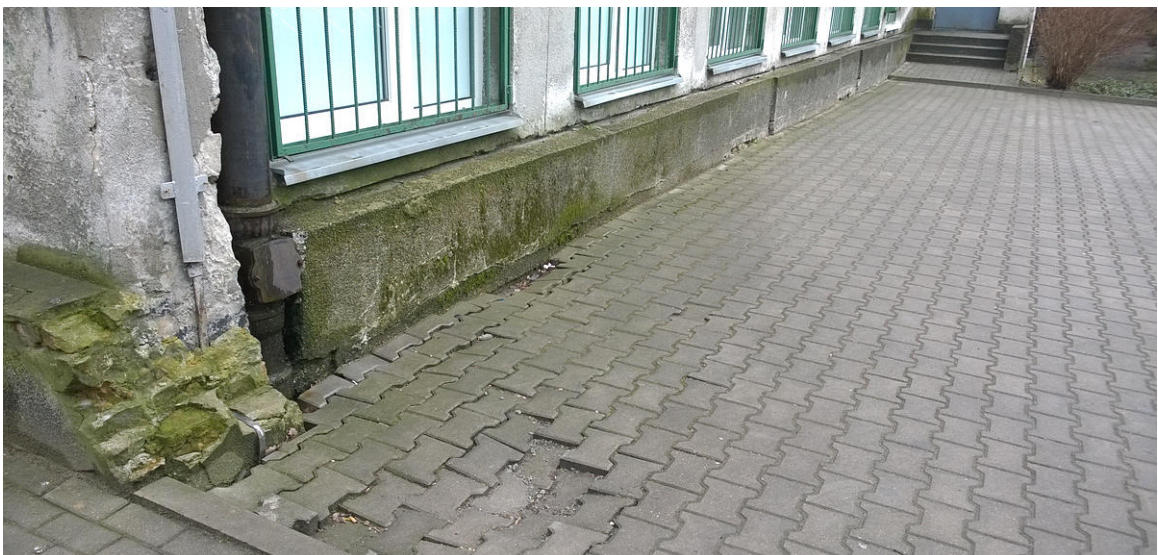
Uszkodzenia nawierzchni i muru na narożniku półn-wsch. budynku głównego.
